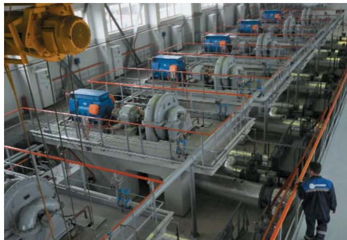
Машинный зал воздуховудных агрегатов
