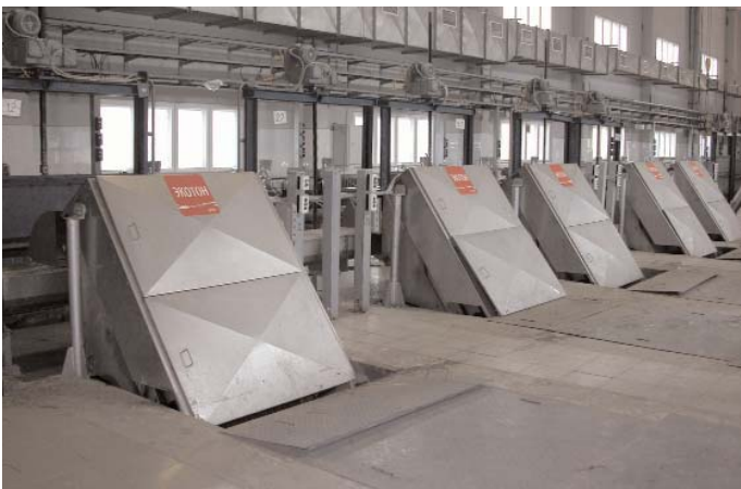
Мелкопрозрачные решетки с системой транспортировки и обезвоживания отбросов «Экотон»
