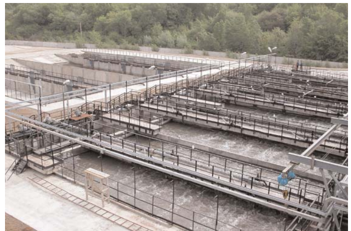
Аэрируемые песколовки. Производительность 530 тыс. м 3 /сут
